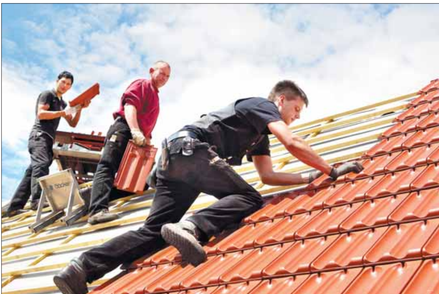
Wer sein Dach neu decken lässt, sollte nicht auf die Dienste von reisenden Handwerkern zurückgreifen, rät die Dachdecker-Innung. Foto: dpa
