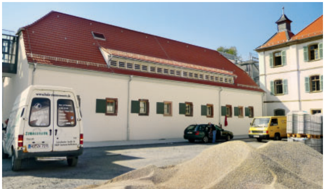
11 Das umgebaute Wirtschaftsgebäude während der Sanierung.
